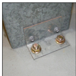
Крепление самонесущих конструкций.
