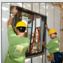
Крепление оконных рам к различным видам оснований
