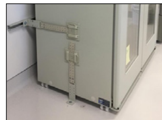
Крепление оборудования.
