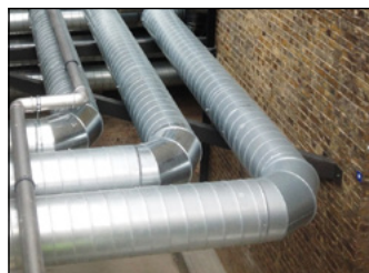
Крепление трубопроводов, воздухопроводов, электрики.
