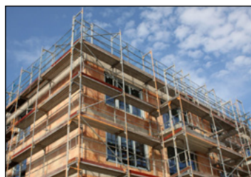
Монтаж строительных лесов.
