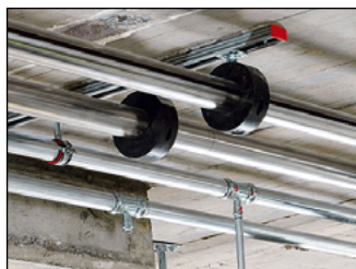
Крепление инженерных сетей.
